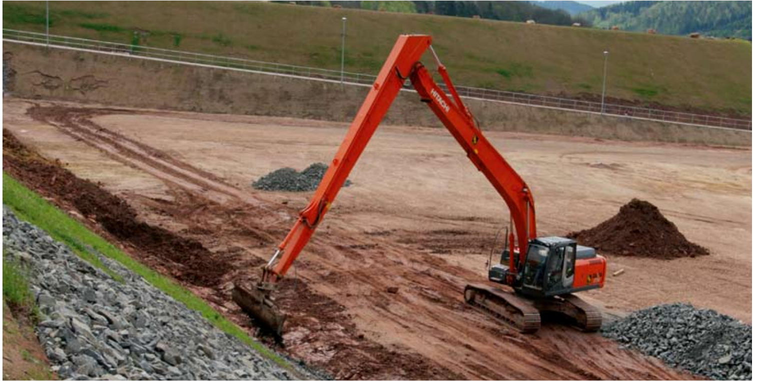
Hitachi ZX250LCN-3 mit Böschung-Super-Long-Front
