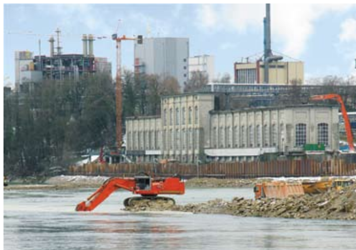
Hitachi EX1200-5 bei Arbeiten am Wasserkraftwerk in Rheinfelden
