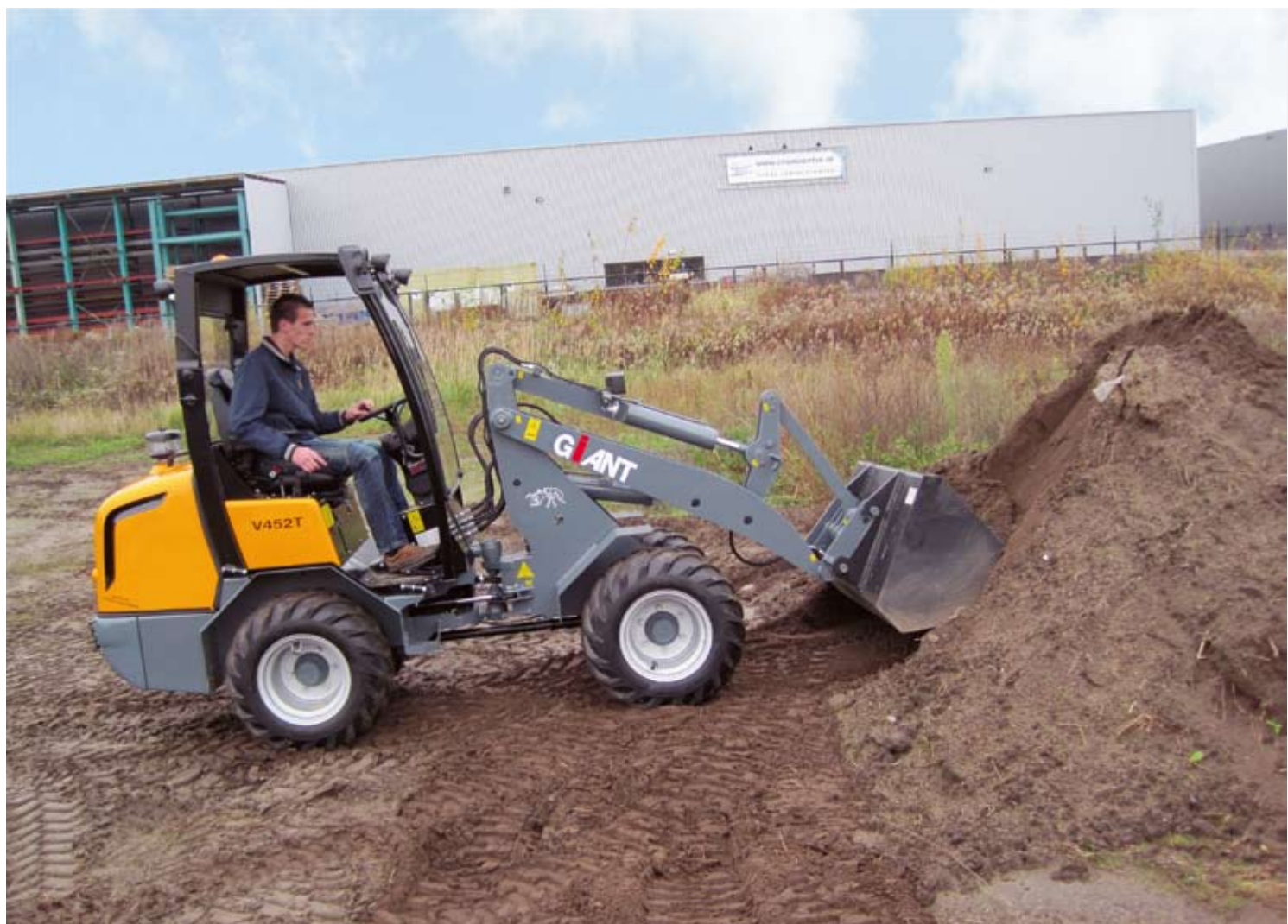
V452T bei Erdarbeiten
