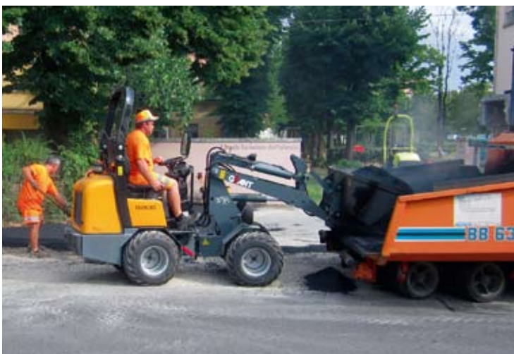
Giant D263S bei Asphaltarbeiten
