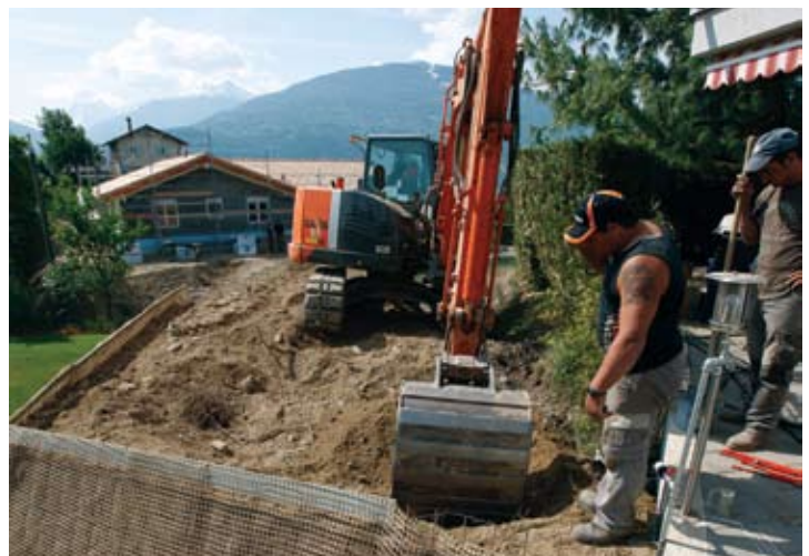
Hitachi ZX85USBL3-3 im Wegebau
