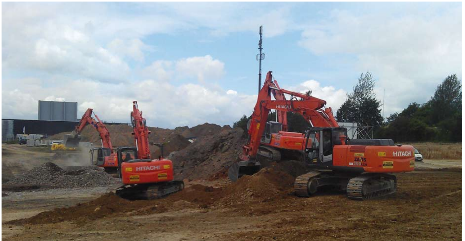
Hitachi Kettenbagger im Verkehrswegebau
