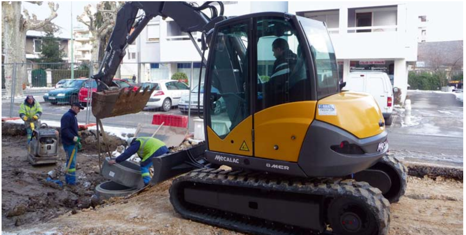
Mecalac 8MCR beim Schacht setzen
