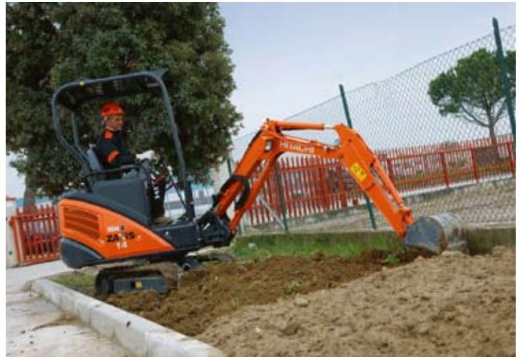
Hitachi ZX14-3 bei Herstellung eines Gehsteigs
