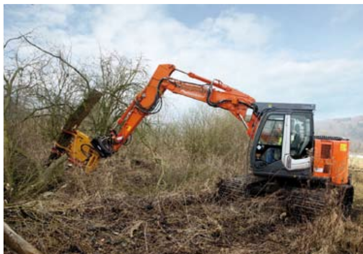
Hitachi ZX135US-3 beim Ausholzen
