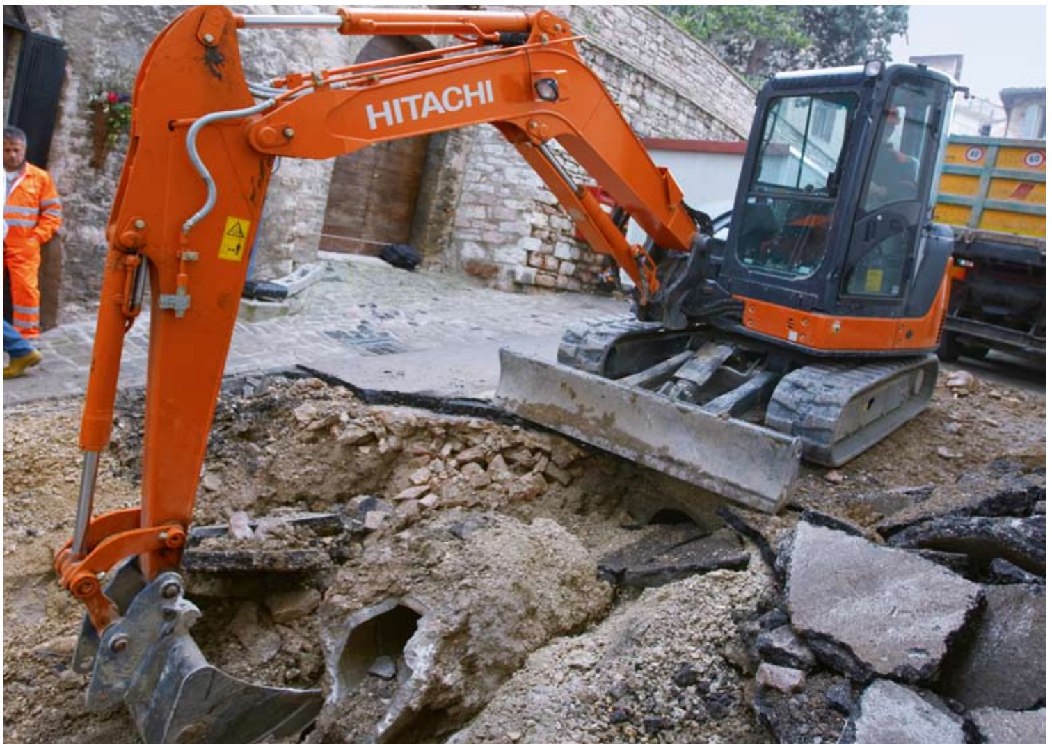
Hitachi ZX60USB-3 bei Straßensanierung
