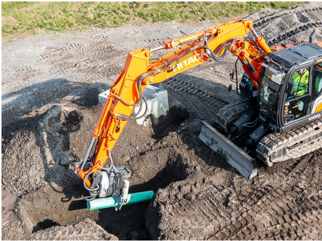
Präzises Positionieren Positioniert Rohre sicher im Graben.
