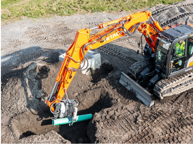
Präzises Positionieren Positioniert Rohre sicher im Graben.
