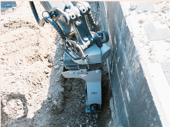
Exzentrische Bauweise für randnahes Arbeiten
