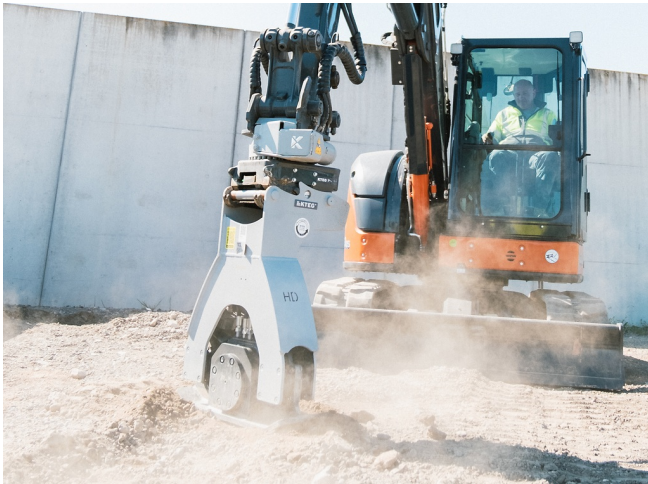
Schnelle und sichere Verdichtung in schmalen Gräben für alle Bodenarten
