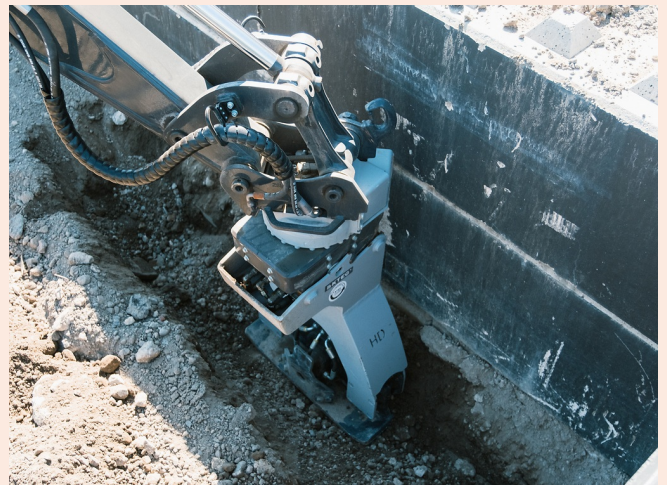
Präzise Verdichtung auch dort, wo sonst nur Handarbeit möglich ist
