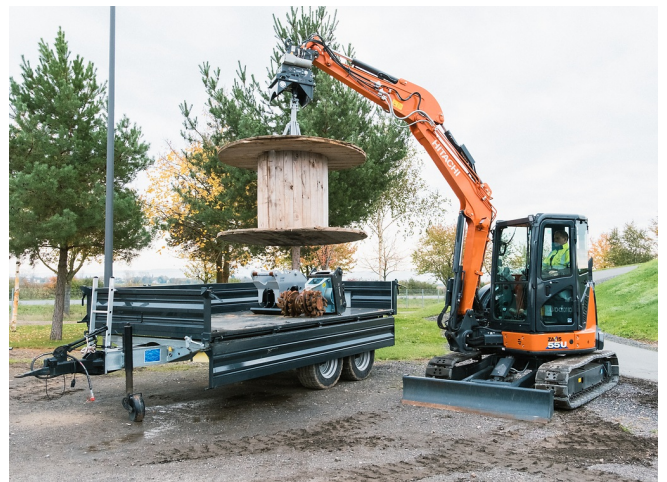
Ein Arbeitsgang: Aufnehmen, Positionieren und Verlegen
