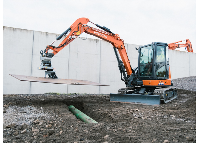
Kraftschlüssiges Anheben und Verlegen der Stahlplatte.
