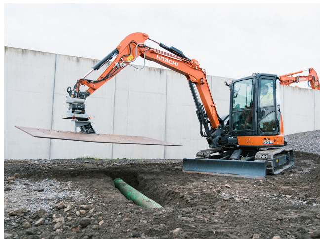
Kraftschlüssiges Anheben und Verlegen der Stahlplatte.
