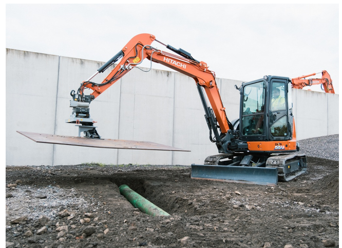
Kraftschlüssiges Anheben und Verlegen der Stahlplatte.
