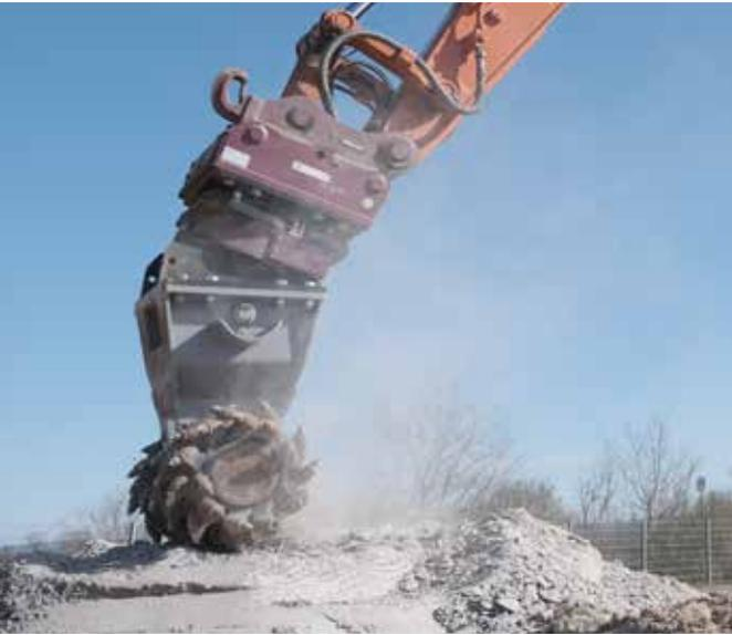
Leistung und Effizienz sind die herausragenden Merkmale unserer ROCKWHEEL Anbaufräsen. Die Antriebskonzepte sind der Maschinenklasse angepasst und erreichen damit das Maximum an Lösekraft. Unsere Fräsen arbeiten lärm- und vibrationsarm. Auch Einsätze unter Wasser sind kein Problem. Ohne weitere Vorkehrungen kann die Fräse unter Wasser eingesetzt werden und löst so Gesteinshärten bis ca. 110 MPa.
