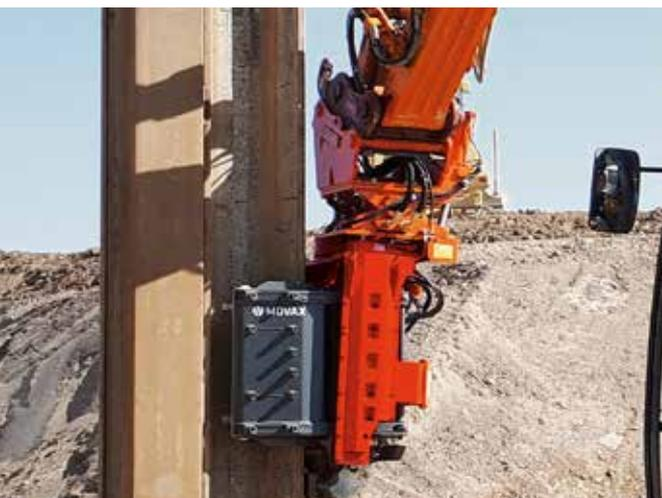
Unsere MOVAX Seitengriff-Vibrationsrammen sind die optimale Lösung für anspruchsvolle Einsatzorte, in denen höchste Präzision erforderlich ist. Aufnehmen, Aufrichten und Einrammen der Spundbohle erfolgt mit demselben Gerät. Anwendungen mit eingeschränkter Arbeitshöhe sind kein Problem. Das variable Exzentermoment erzeugt keine kritischen Frequenzen und schont die Baustellenumgebung.
