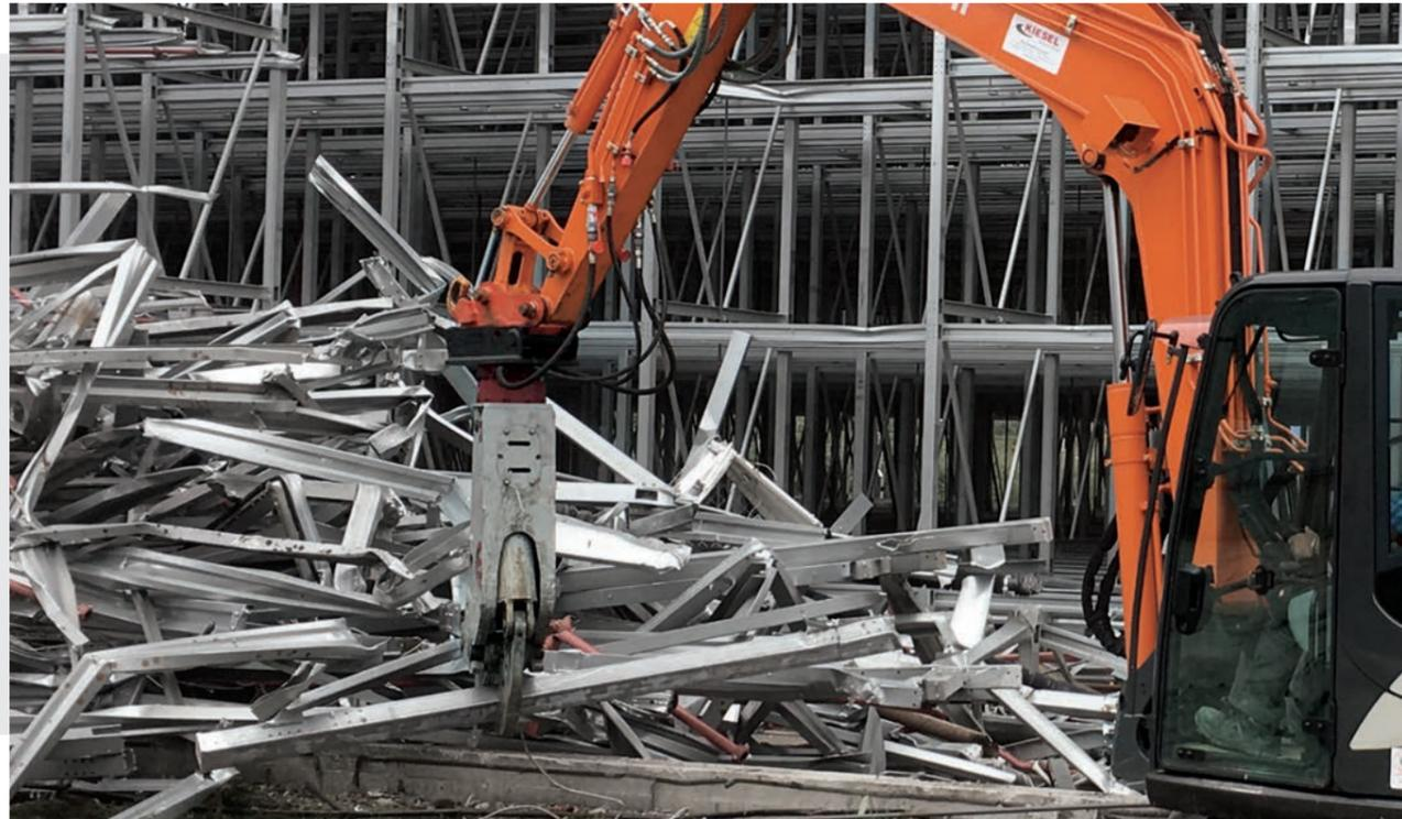
Leistung in der Kompaktklasse - DMS05 zerkleinert tonnenweise Stahlkonstruktionen
