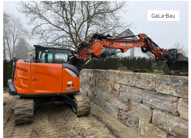
Hitachi ZX95US-7 VA MTC mit KTEG 360° mit Grabenräumlöffel.
