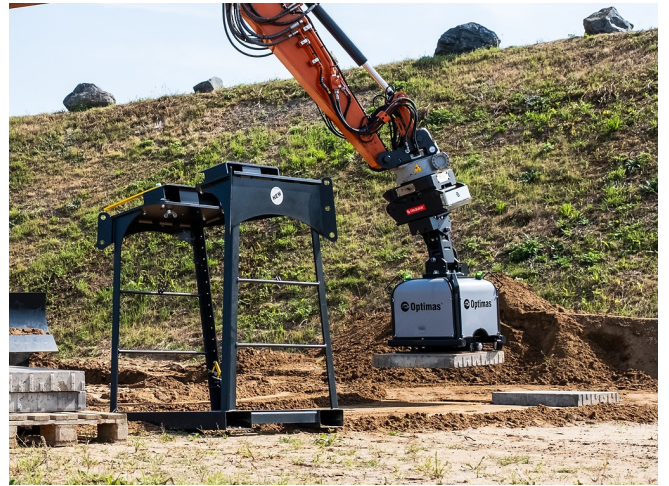
Gesundheitsschonend schwere Platten und Bordsteine verlegen
