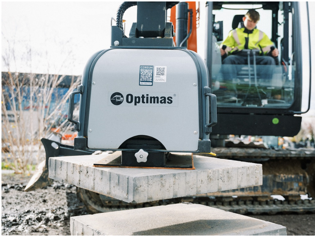
Sicheres Anheben von Steinplatten
