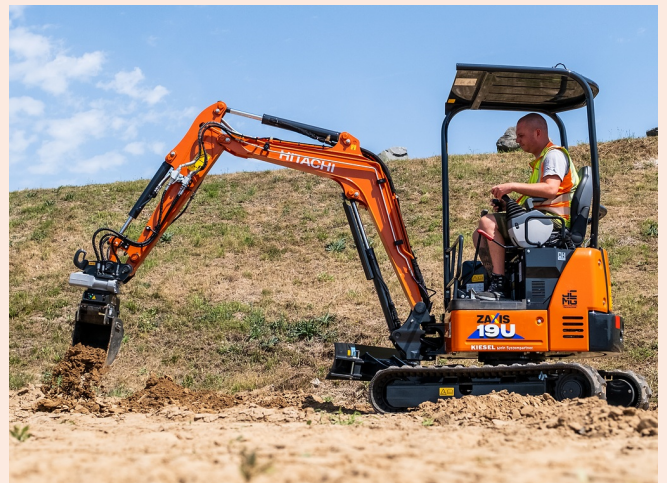
Schnelles und sauberes Rückverfüllen durch seitlich gedrehten Tieflöffel
