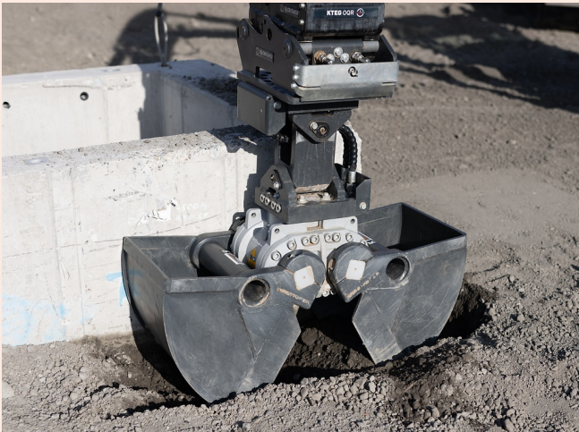
Senkrechtes Graben bis an Bauwerkskanten
