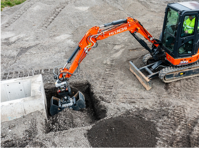
Mechanisierung und Prozessoptimierung auf jeder Baustelle: Mind. 50% weniger Handschachtung
