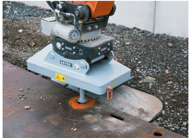
Dorn in vorgesehene Bohrung einsetzen
