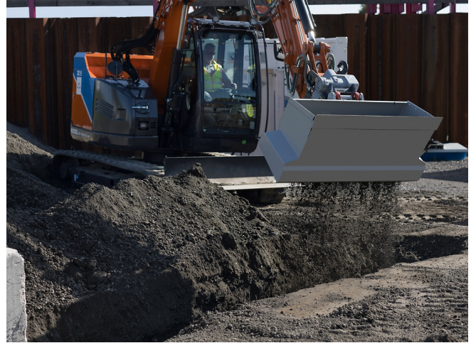
Gesiebtes Material wird direkt und sauber in den Graben zurückverfüllt
