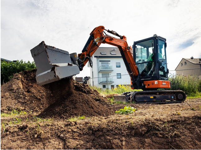
Sieben und Aufbereiten von Material direkt auf der Baustelle
