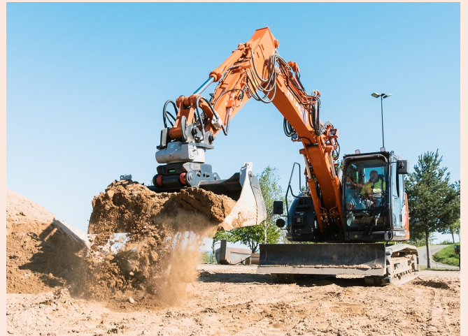
Mit KTEG OQR: Der Bagger wird zum Radlader
