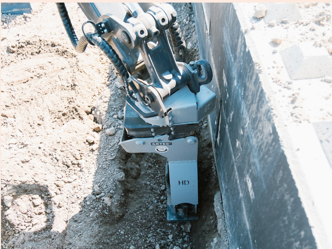
Exzentrische Bauweise für randnahes Arbeiten
