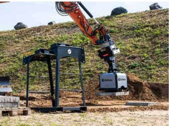
Ergonomisches Verlegen Verlegt schwere Platten und Bordsteine ohne körperliche Belastung.
