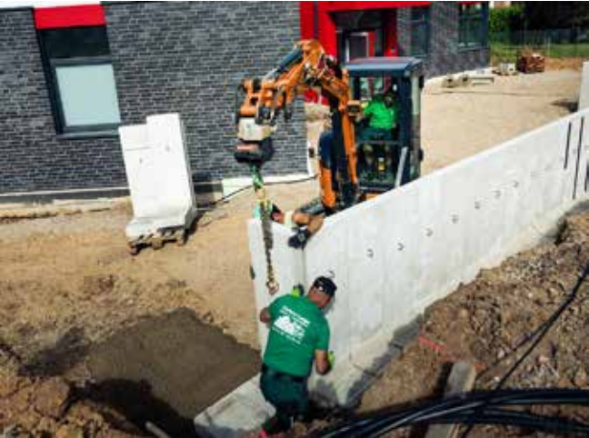
Präzises Versetzen von Betonelementen Sicheres Positionieren schwerer Bauteile direkt an der Einbaustelle.
