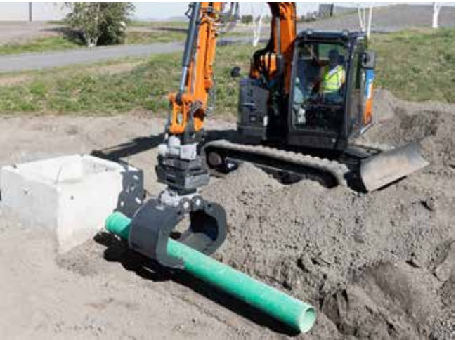
Rohrverlegung Rohre sicher direkt im Graben positionieren.
