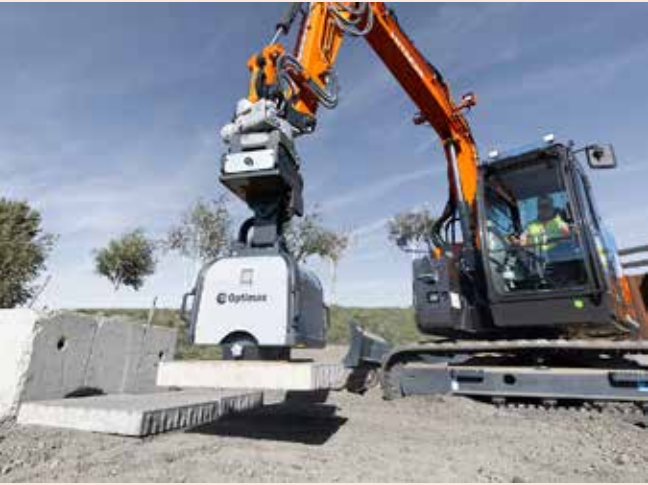
Präzise Positionierung Positioniert Bauteile exakt ohne Personen im Gefahrenbereich.
