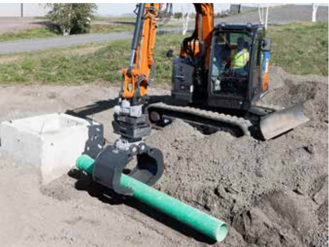
Rohrverlegung Rohre sicher direkt im Graben positionieren.
