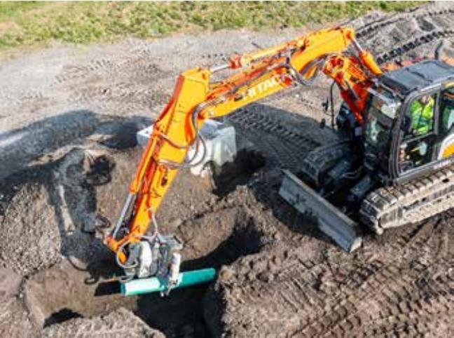
Präzises Positionieren Positioniert Rohre sicher im Graben.
