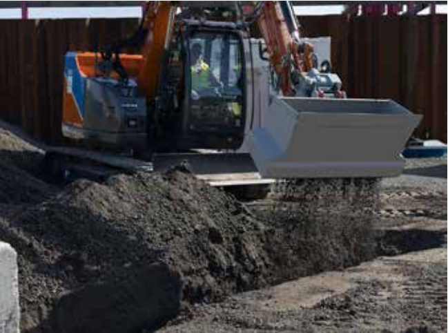
Sauberes Rückverfüllen Bringt gesiebtes Material kontrolliert zurück in den Graben.
