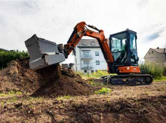
Materialaufbereitung Siebt und trennt Material direkt auf der Baustelle.
