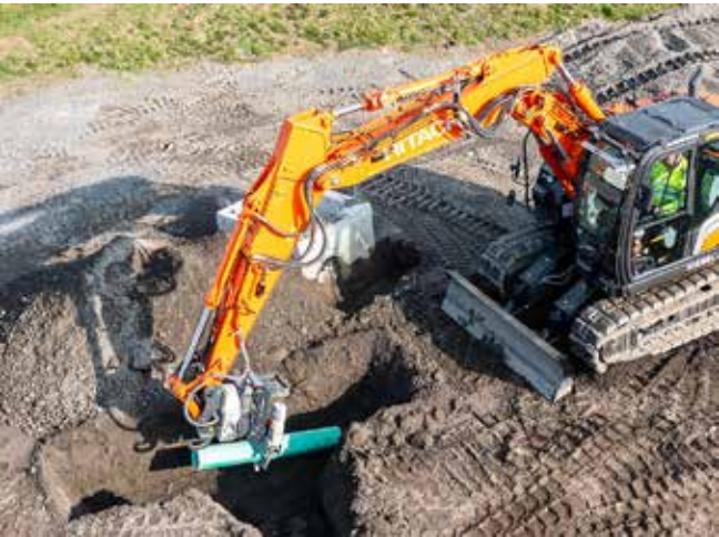
Präzises Positionieren Positioniert Rohre sicher im Graben.
