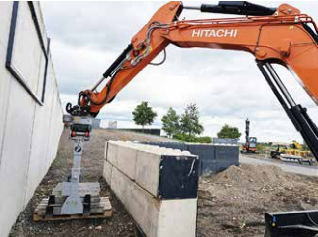
Sicheres Versetzen Transportiert Lasten auch über Hindernisse hinweg.
