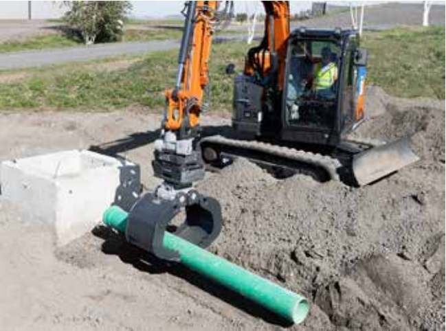
Rohrverlegung Rohre sicher direkt im Graben positionieren.
